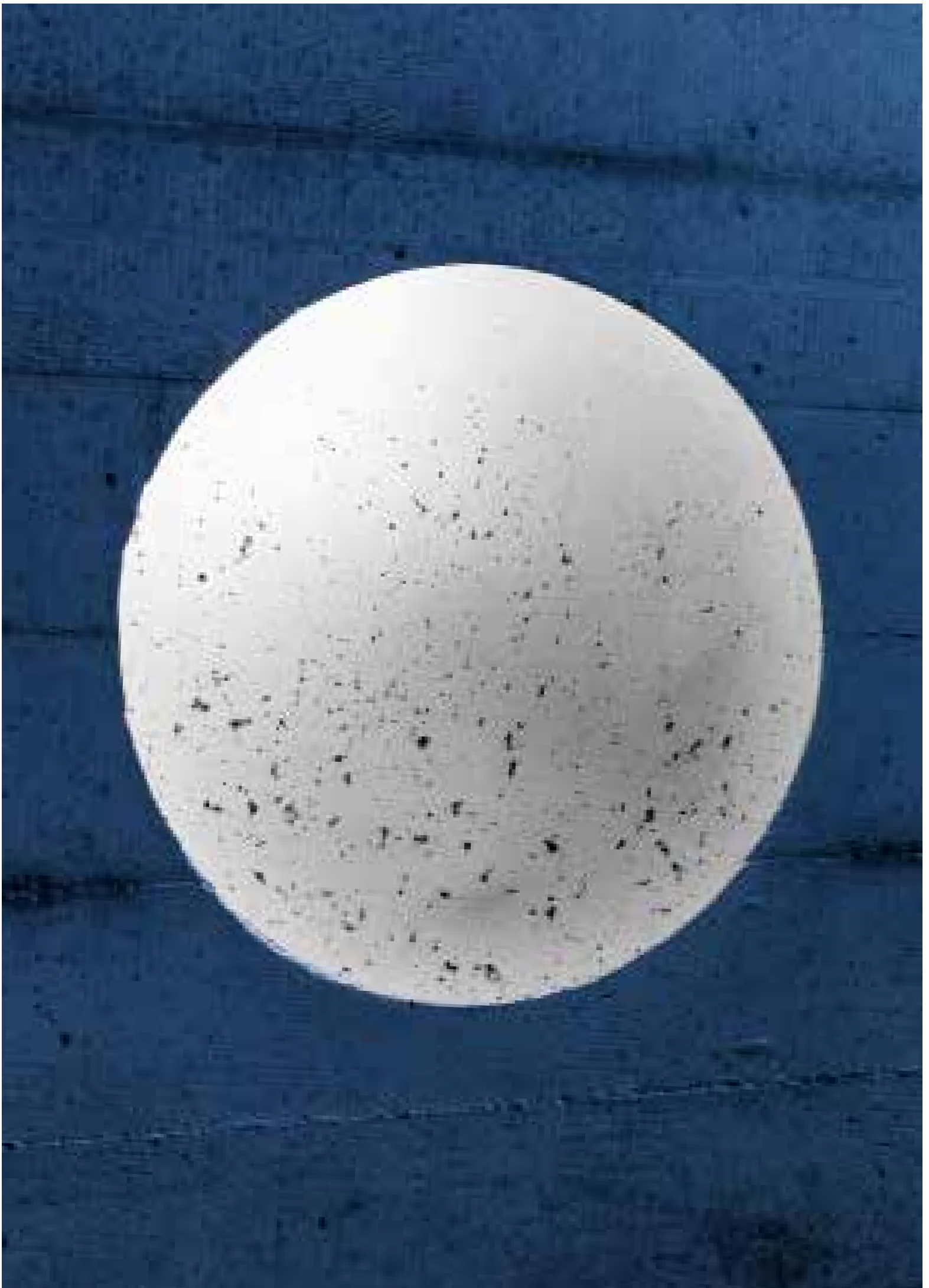
Inszeniert im blauen Licht des Fotografen: Der Beton an der Wand erscheint in der rauen Form der Holzschalung, die Vertiefung für Jörg Boners Leuchte ist glatt gegossen.
